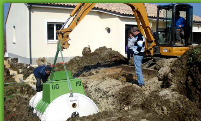
Installation d'une Tricel Novo FR6
