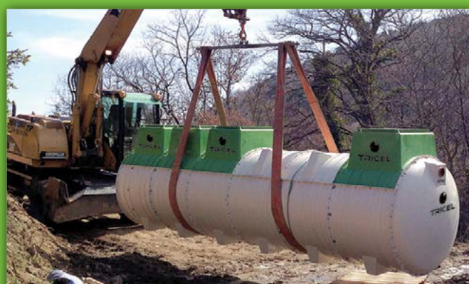
Installation d'une Tricel Novo FR20
